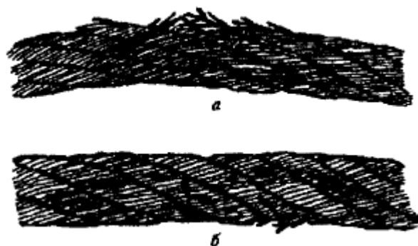
Рисунок 3. Обрывы проволок в зоне уравнительного блока:
